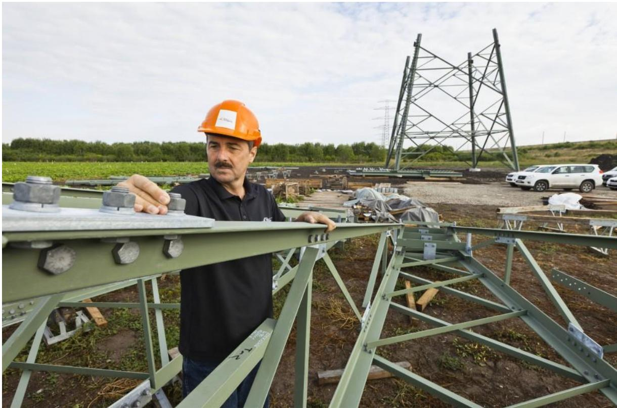
*Baukontrolleur überprüft Schraubverbindungen an Segmenten für Höchstspannungsmasten an einer im Bau befindlichen 380-kV-Höchstspannungsleitung bei Wipfratal in Thüringen. Wie laut die fertigen Trassen im Betrieb nachher werden, hängt sowohl von der verwendeten Technik (Gleich- oder Wechselstrom) als auch von der Witterung und den genutzten Leiterseilen ab.*
