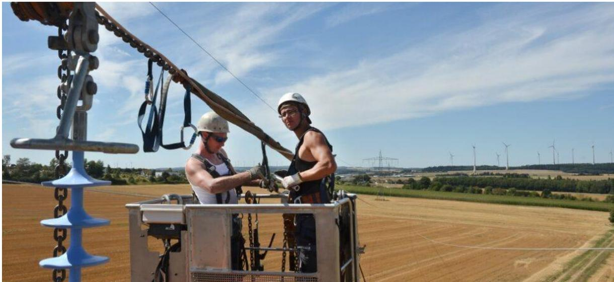
*Montage eines Leiterseils an einer Stromtrasse. Sind die Seile einmal montiert, stehen die Masten mit ihrer Ausrüstung nicht einfach ruhig in der Landschaft herum. Hochspannung lärmt, sagen manche, auf jeden Fall gibt es Betriebsgeräusche und daher unterliegt so ein Trassenbetrieb der TA Lärm. Im Juli hat jetzt eine Novelle des Energiewirtschaftsgesetzes deren Regelung für Höchstspannungsnetze de facto ausgehebelt.*
