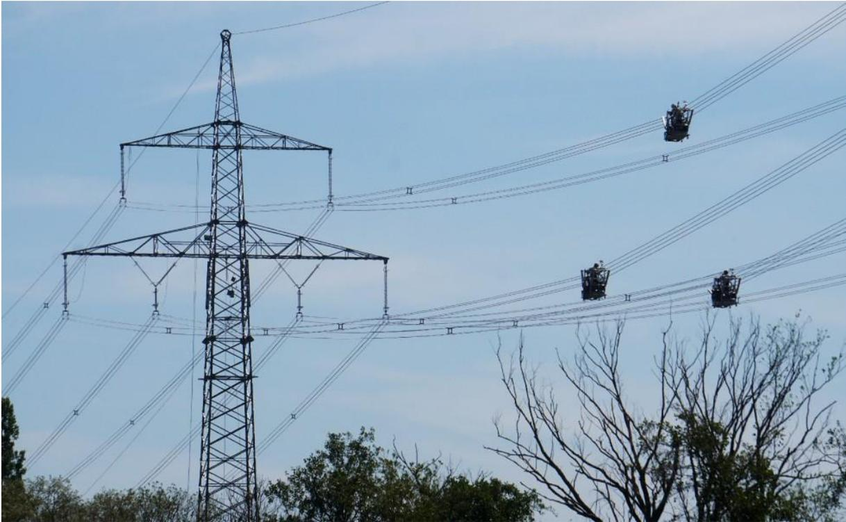
*Das Umspannwerk Erlangen-Kriegensbrunn ist über eine Kuppelleitung mit der 380-kV-Hochspannungstrasse Würgau-Raitersaich (Rosstal) verbunden. Die bisher doppelten Leiterseile wurden durch Vierleiter-Systeme ersetzt. In den Masten und auf den (strom- und spannungslosen) Leitungen sind die Umbauteams zu sehen.*
